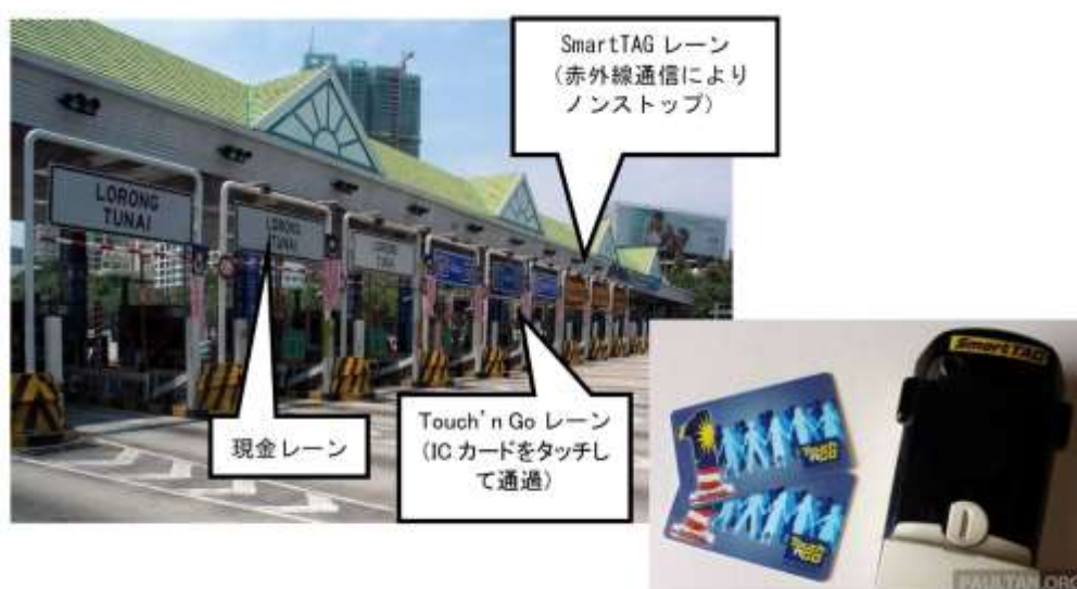
図 2-95 マレーシアの高速道路料金所（左）と IC カード・車載器（右）
