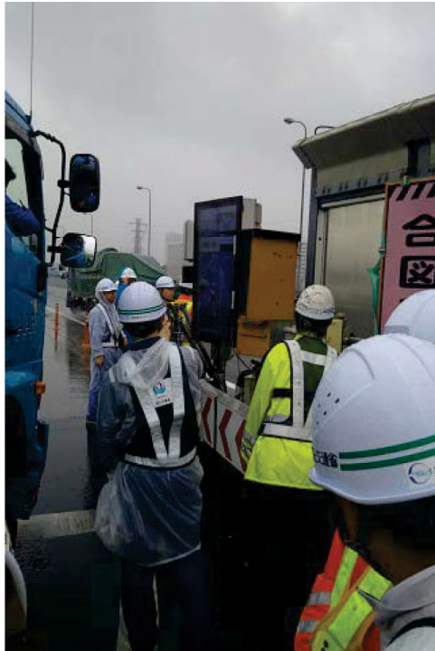
工事車両待機部
