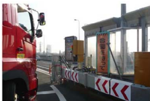
合流車発進点運転手向け 設備全景
