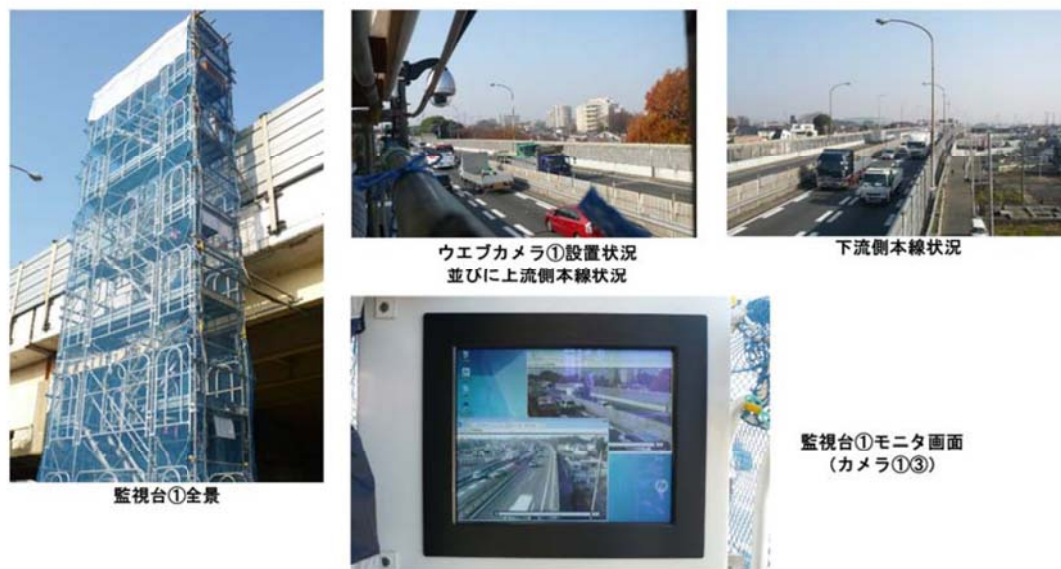
図 3-50 監視台①の現場設備状況
