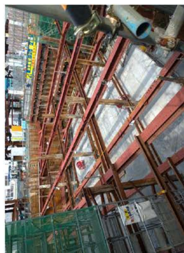
ランプ部開削ボックス施工状況(東名JCT)
